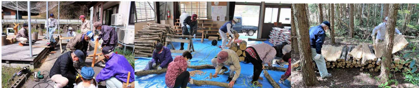
4月6日「作業台づくり」
