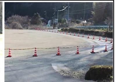
振興センター敷地内の通路、グラウンドに凸凹が多くなり、水たまりができるようになったため、真砂土を10トンダンプ2台分入れ、八銚落合自治会“松永光昭さん”へユンボとトラクターで整地をしていただきました。
