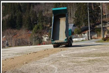
3/26グラウンドへ西城運輸砕石(株)より、大型ダンプ3台分の真砂土を搬入
